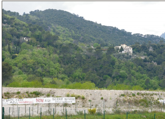
C'est sur ce site, en bordure d'Estéron qu'est prévue la centrale de cogénération par la biomasse. (Photo archive N.M)
